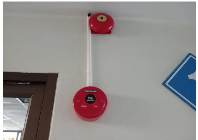
รูปที่ 11 สัญญาณระบบเตือนภัยภายในอาคาร
