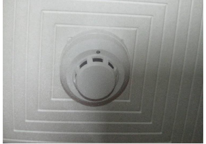
รูปที่ 14 เครื่องตรวจจับความร้อน
